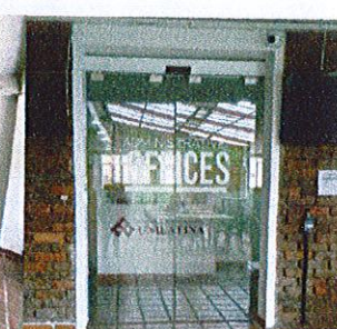
Puertas accesos segundo piso
